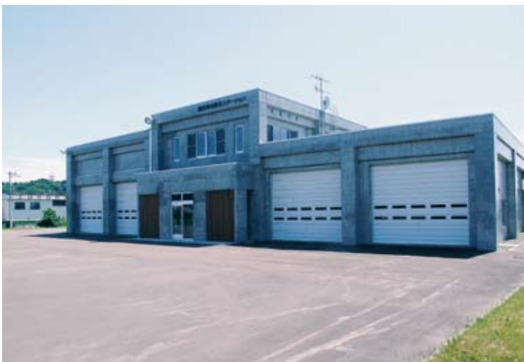
標茶町防災ステーション
