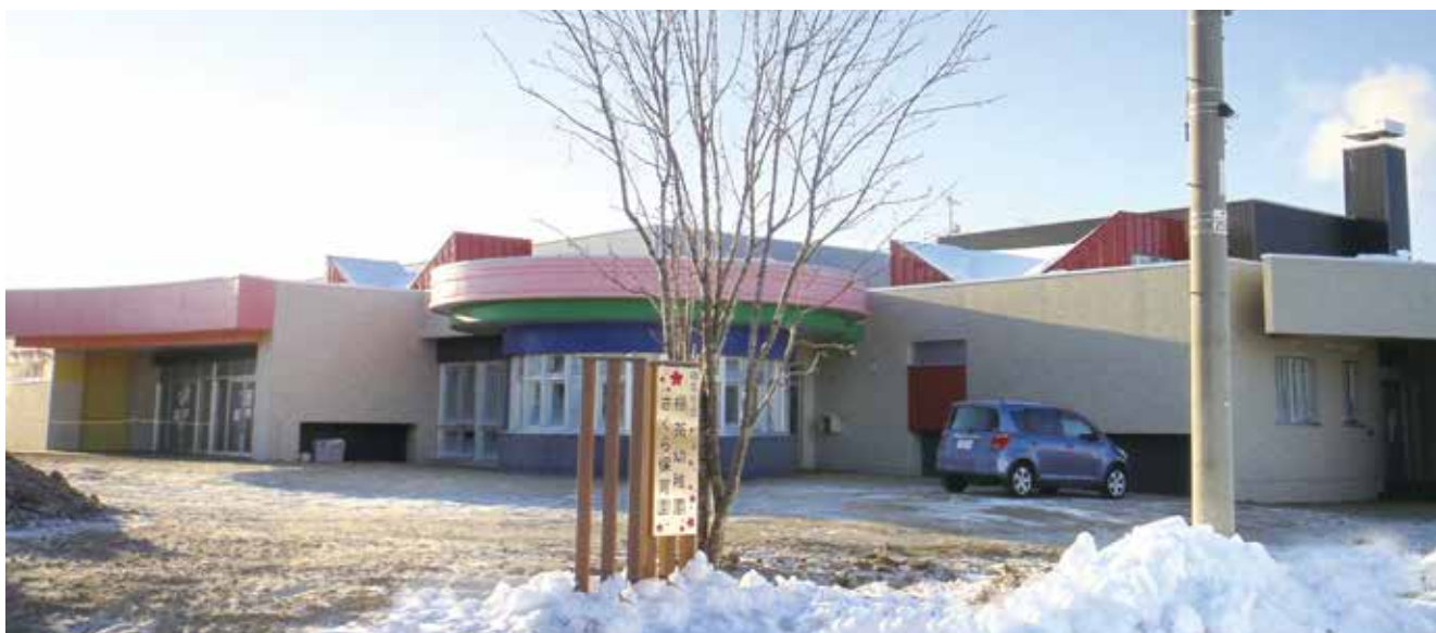
— 完成した町立幼稚園・桜保育園 —
