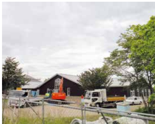
磯分内小学校改築工事
