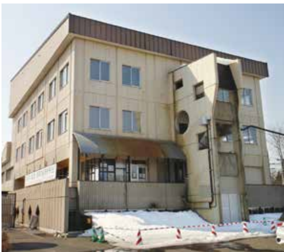
改築が必要な役場庁舎
