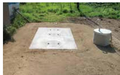
合併処理浄化槽
