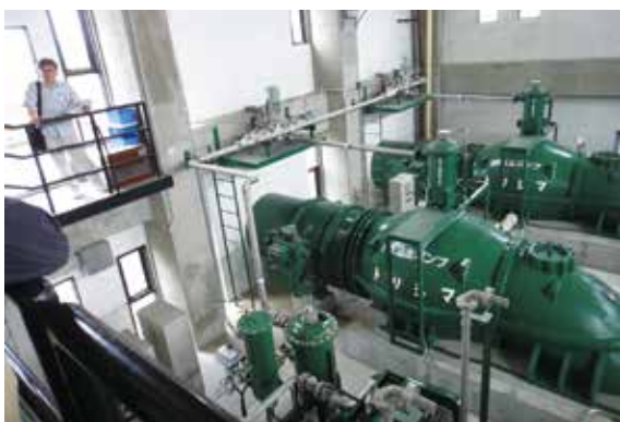
排水機場ポンプ
