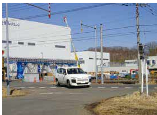
国道への出入口
