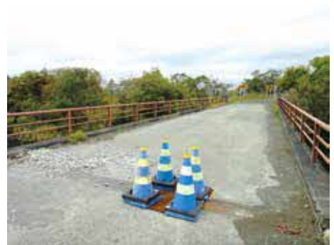
改修工事が待たれる二本松橋
