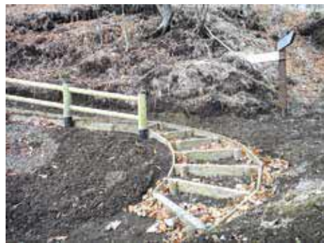
補修されたサルボ展望台周辺
