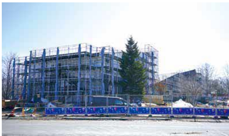
建設中の憩の家かや沼
