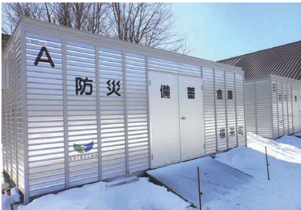
トレセン防災備蓄倉庫
