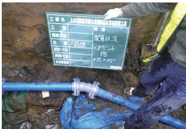
水道管耐震化工事
