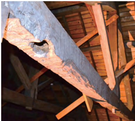
官署の天井裏に使われている二重梁。ウロのある原木を、手作業で削った跡が残る。
