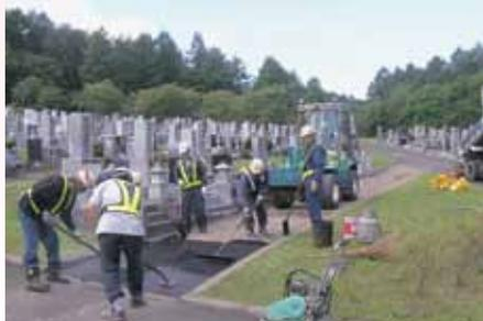
のアスファルト舗装の補修作業をしてくださいました。この日は劣化していた舗装をバックホーで剥がした後、路盤の転圧をして、新たにアスファルト舗装をしてくださいました。
